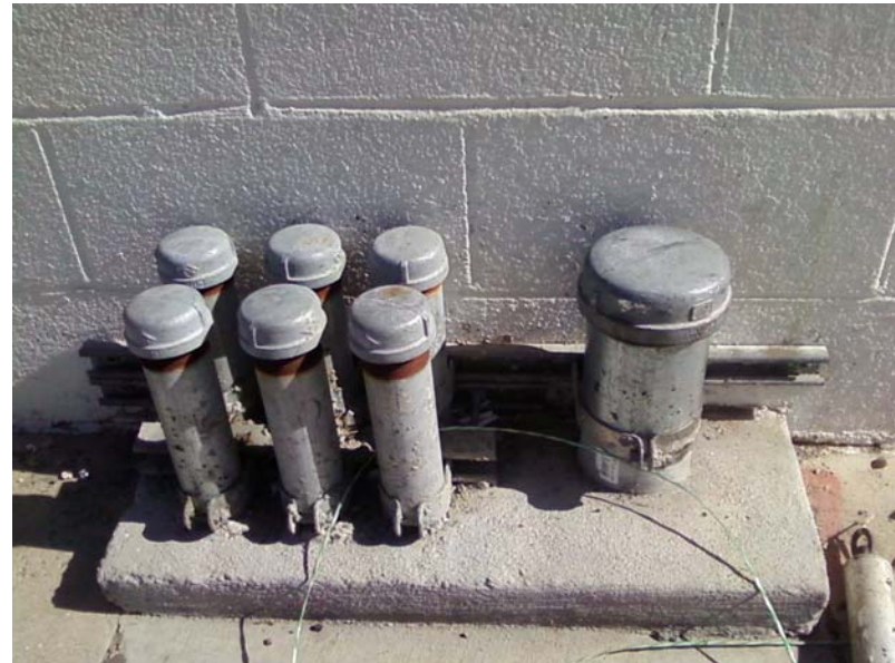
Checking all conduit terminations
